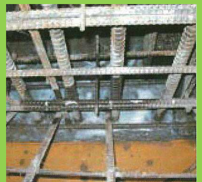
ジョイントエース散布後
