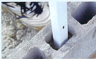
支柱を立てます。
